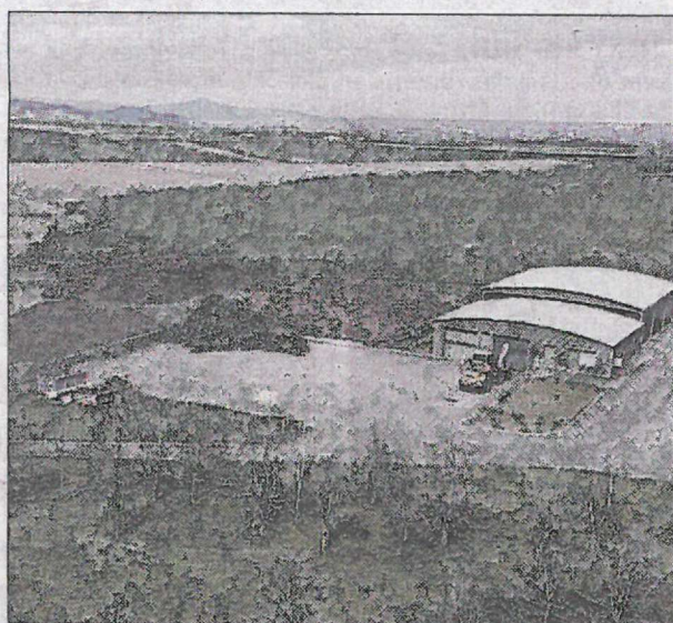
La plateforme de compostage de Charbonnier-les-Mines et ses andains vus du ciel. (PHOTO : SICTOM ISSOIRE-BRIOUDE)
