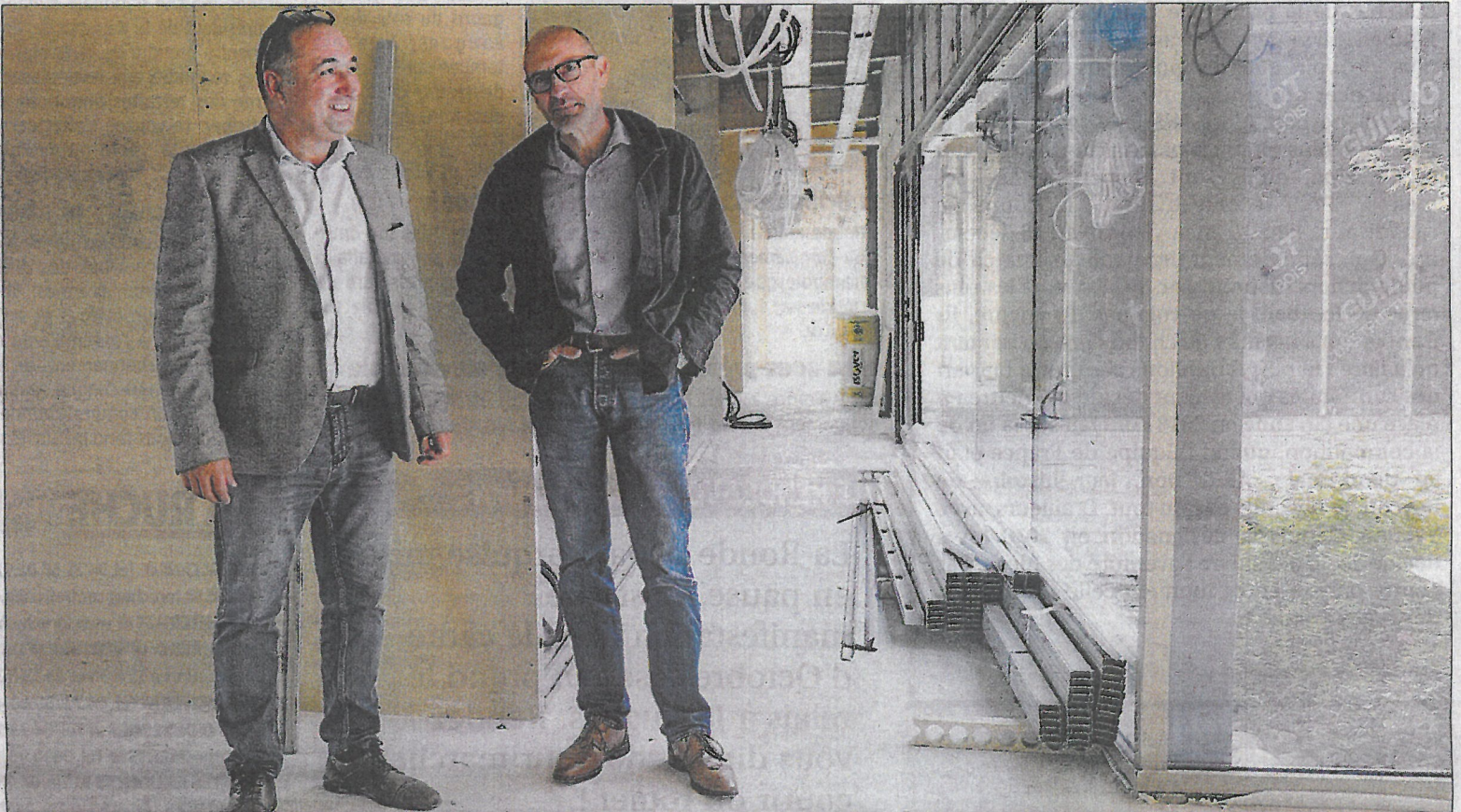
Serge Batisse (à gauche) et Pierre Ravel, suivent de près l'avancement des travaux du nouveau siège. (PHOTO : N. JACQUET)
